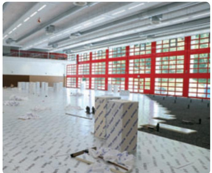
Am Ende der zweiten Arbeitswoche, die Aufnahme wurde am Pfingstsonntag gemacht, war bis auf den südöstlichen Bereich der Halle die erste Lage an PUR-Dämmplatten komplett verlegt.
