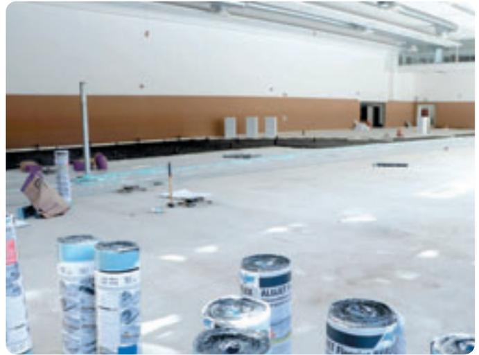
Die Karl Laue-Halle zu Beginn der ersten Arbeitswoche (links) und in der Mitte der zweiten Woche. Der Kunststoffschaum (linkes Foto, links) und die Holzplatten sind inzwischen abgetragen. Auf die Rohbetondecke kommen Abdichtungsbahnen zum Schutz gegen Feuchtigkeit (rechtes Foto vorne). Auf den Bahnen wird anschließend eine Ausgleichsschüttung verteilt (schwarzes Material auf dem rechten Foto hinten) und dann die erste Lage an PUR-Dämmplatten verlegt.
