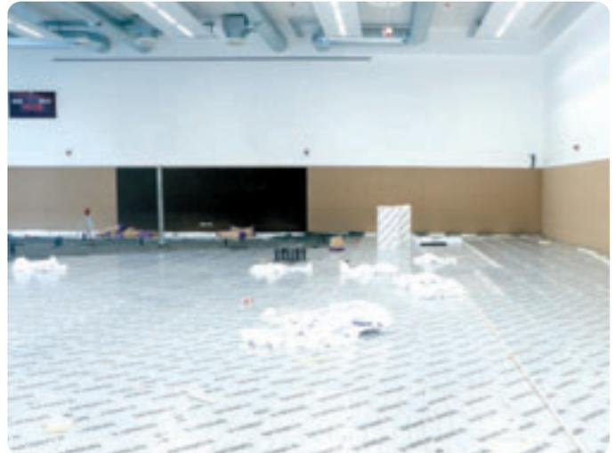
Die linke Aufnahme zeigt den Hallenbodenabriss am zweiten Tag. Das rechte Foto dieselbe Fläche am Ende der zweiten Arbeitswoche. Über der schwarzen Ausgleichsschüttung wurde die erste Lage PUR-Dämmplatten (5 Zentimeter hoch) verlegt. Zum Teil wurde auch schon mit der zweiten Lage begonnen.
